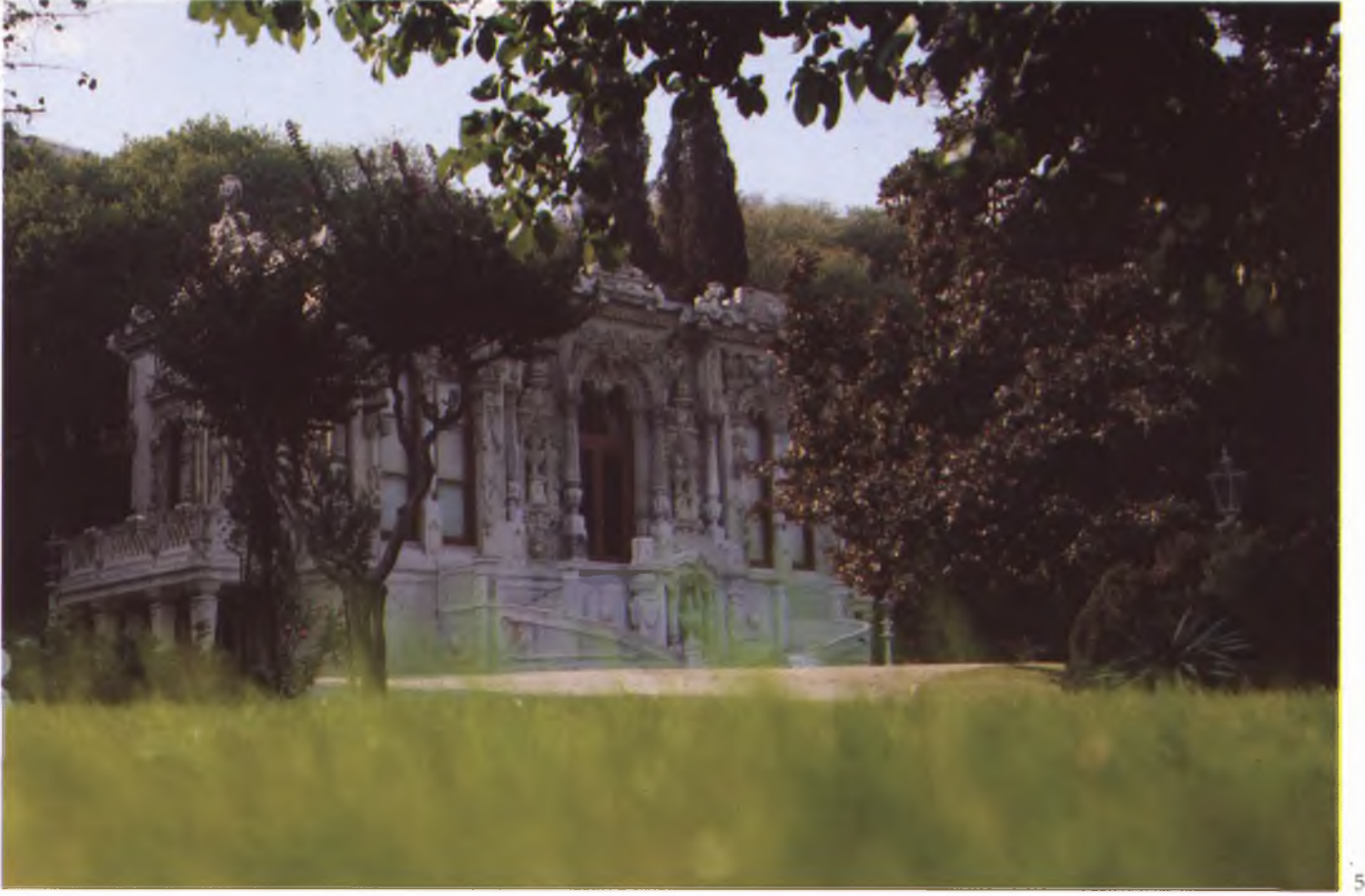
4 Merasim Köşkü'nün ince taş işçilikli cephesine havuzdan bakış.
